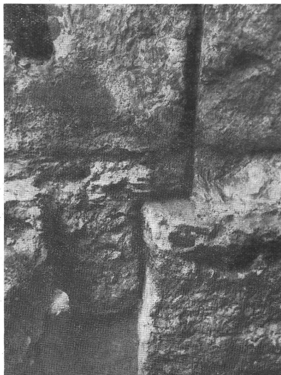
13. kép. A gótikus torony és északi kápolna feltárása. A kápolna alapozása ráépül a torony külső támpillérének alapozására Mise a jour de la tour ogivale et de la chapelle côté nord. Les fondations de la chapelle ont été posées sur les fondations du contrefort extérieur de la tour
