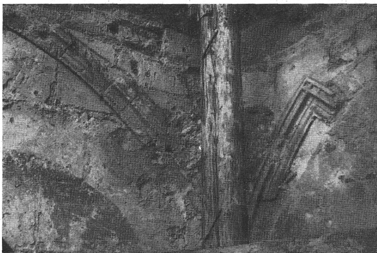
14. kép. A torony északi kápolnájában előkerült gótikus boltozat maradványa a helyreállítás előtt Restes de la voute ogivale découverts dans la chapelle de l'église côté nord avant la restauration.
