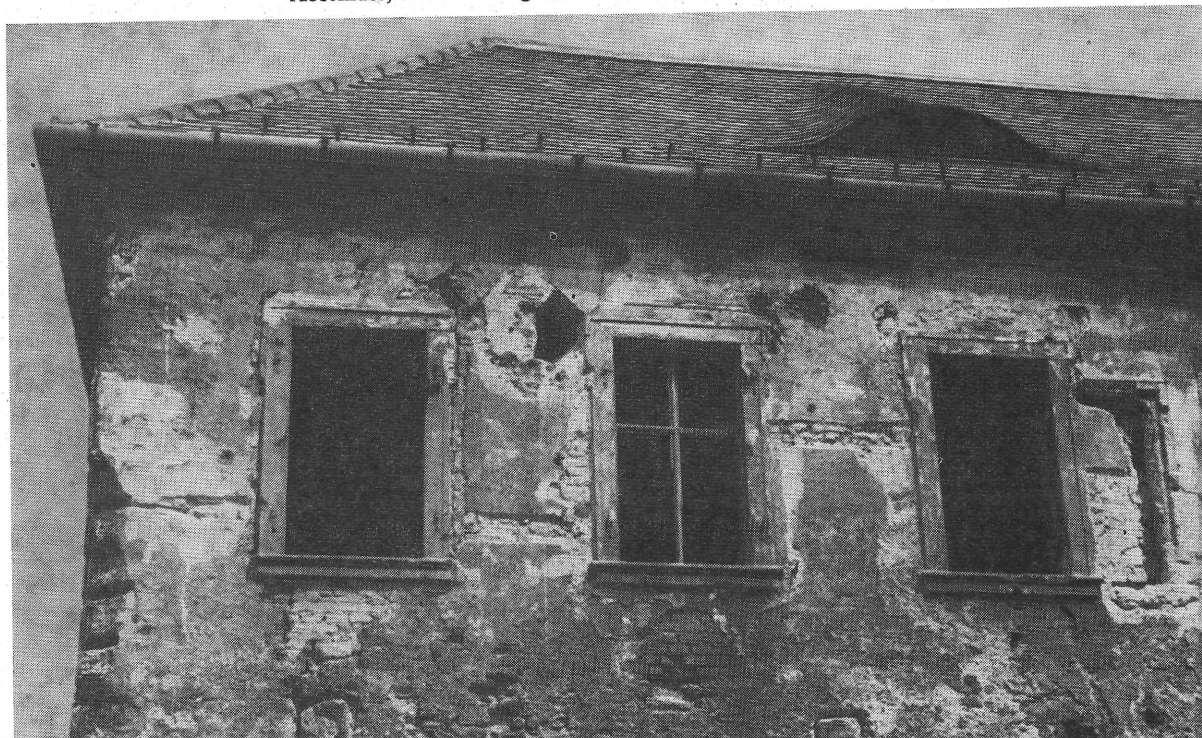
8. kép. Az épület Úri utcai homlokzatának északi, emeleti része. A bal oldali két ablak között a reneszánsz „Károablak” kibontás közben, jobb szélén a vízszintes záradékú ablak maradványa, alul a letört függőfolyosó-konzolok Nördlicher Teil des Stockwerkes in der Fassade des Gebäudes der Úri-Gasse. Zwischen den beiden linksseitigen Fenstern das „Karofenster” im Renaissancestil während der Freilegung, am rechten Rand der Rest des Fensters mit waagerechtem Abschluss, unten die abgebrochenen Konsolen des Aussenganges
