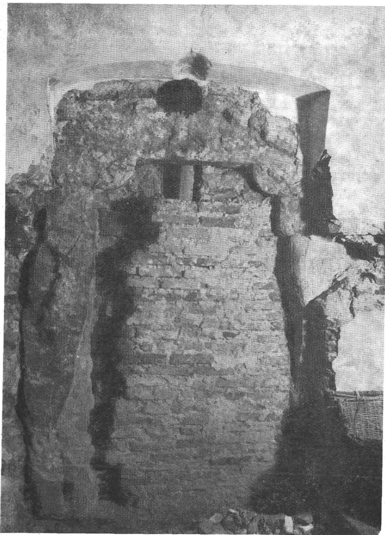
12. kép. Az Anna utcai traktus homlokfalra merőleges válaszfalának ajtókeretkőve a feltárás után
