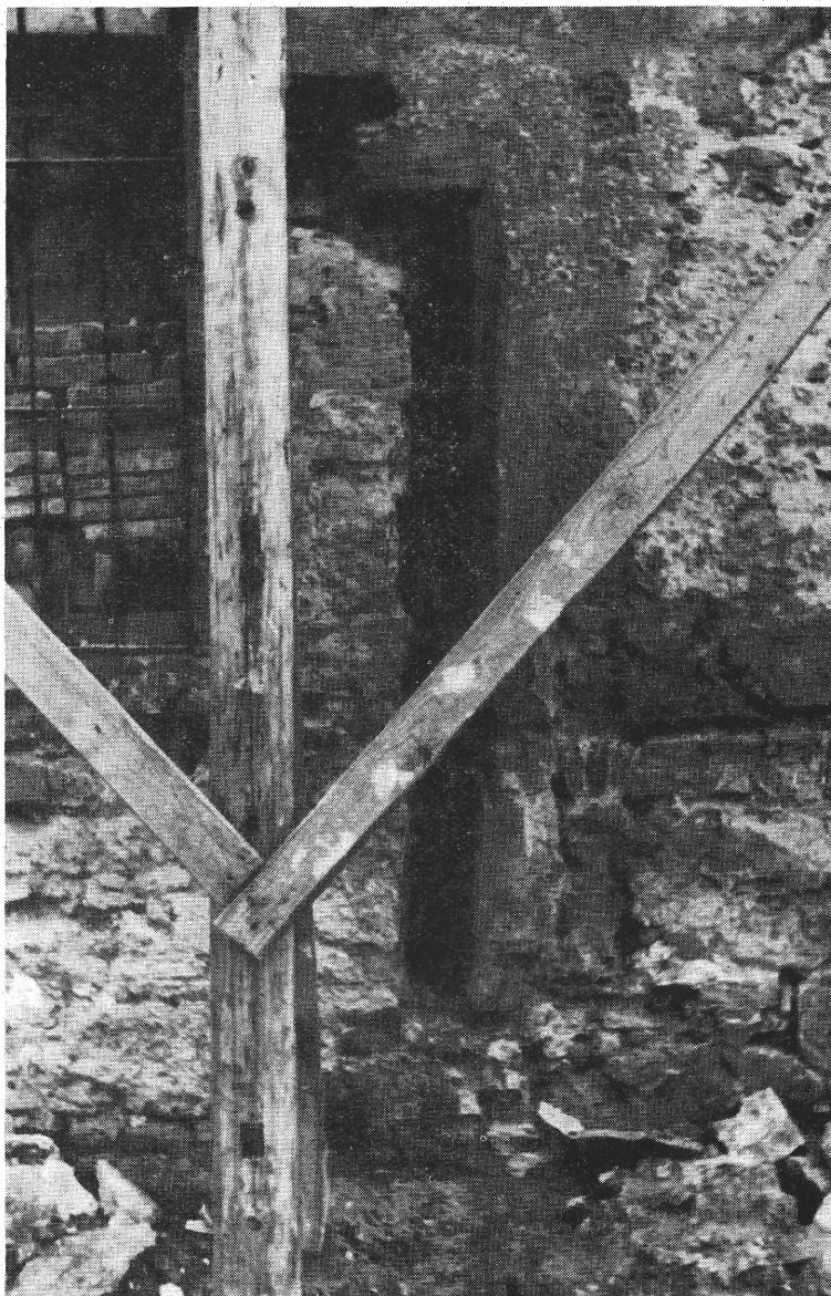
11. kép. Az Anna utcai homlokzat földszinti üzletajtájának maradványa feltárás közben
