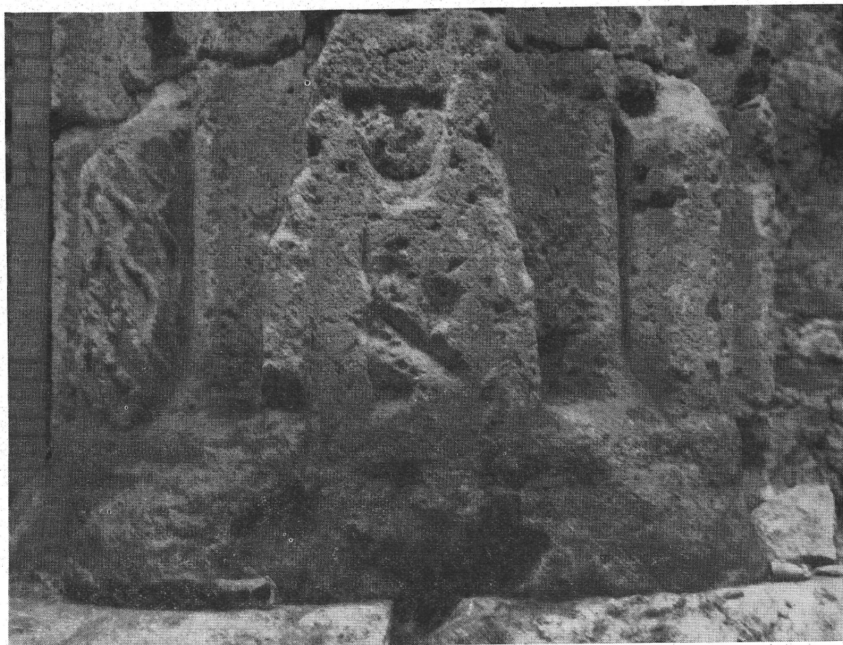
9. kép. A déli falpillér lábázat feletti rétegekőve a héber felirattal Pierre d'assise au-dessus du dé du pilier de mur méridional avec inscription en hébreu
