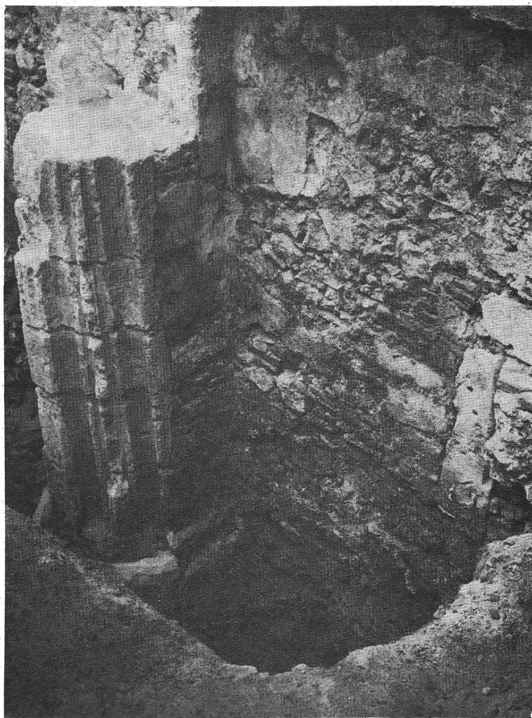
6. kép. A déli falpillér és a női imahely el- falazott ablakának részlete Détail du pilier de mur méridional et de la fenêtre condamnée de la matronée
