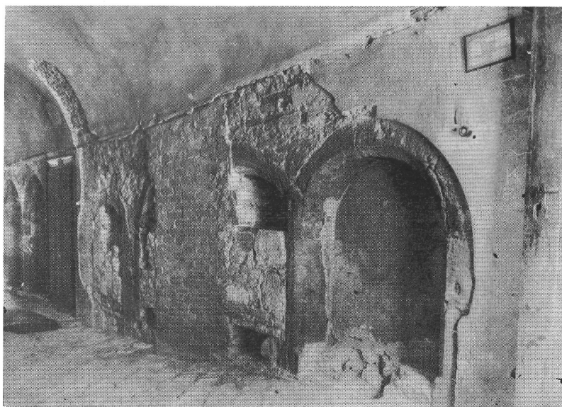
8. kép. Az Űri utca 34. sz. épület kapualjának északi falában levő ülőfülkesor feltárás után
