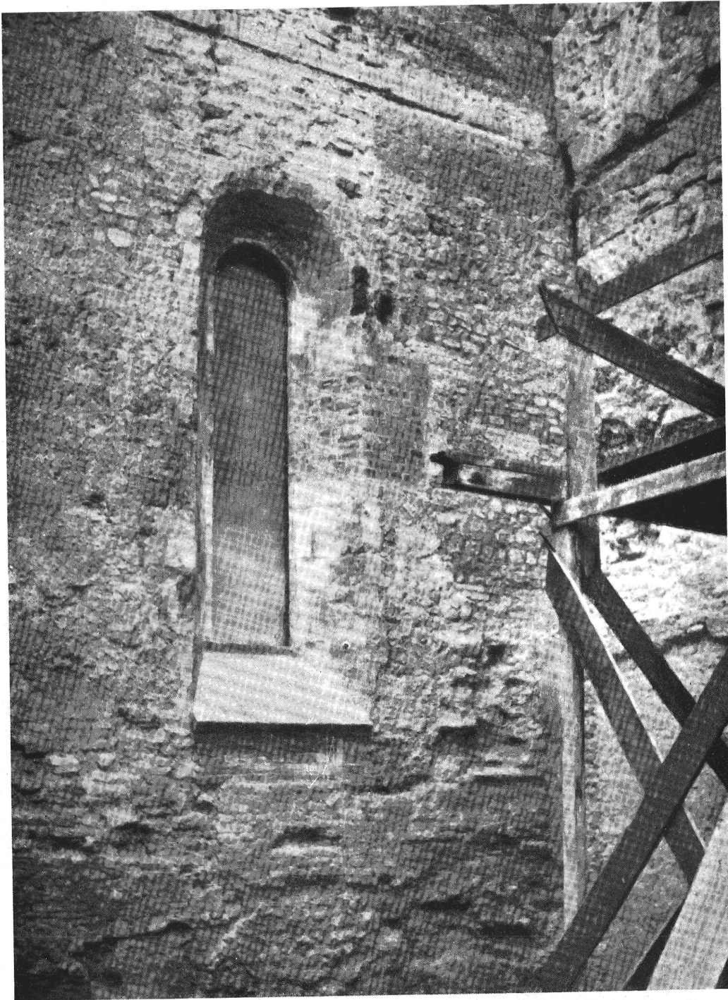
10. kép. — Restaurált románkori templom-ablak a torony és templomfal csatlakozásával.
