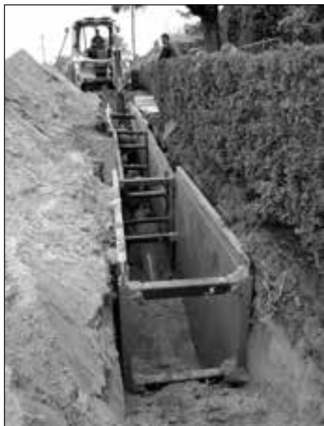
1. kép: Mobil dúcos csatornafektetés Fig. 1: Duct laying with a mobile formwork
