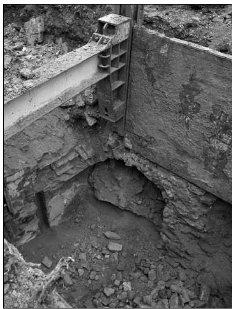
9. kép: A Várkioszkból a Duna partra vezető, korábban ismeretlen, északi alagút bontás közben Fig. 9: Section of the ‘north tunnel’ once used to connecting the Várkioszk with the bank of the Danube, but later forgotten and now cut through by the trench of the Main Sewer unexpectedly
