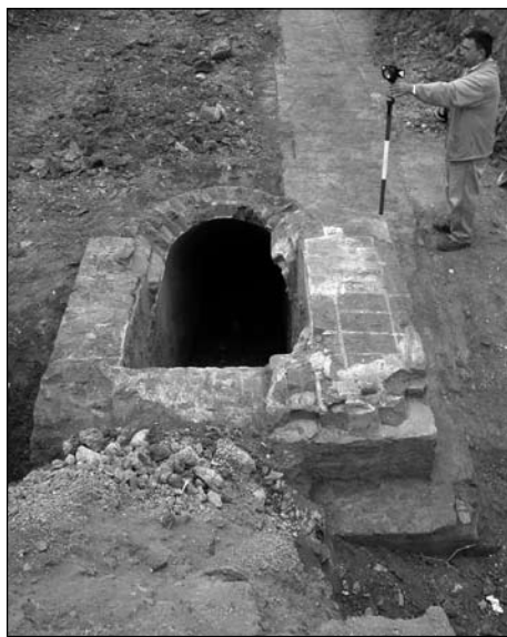
13. kép: Lejárati akna a földalatti víztároló, illetve szűrő helyiségsor keleti oldalán húzódó, észak-déli alagút északi végén
