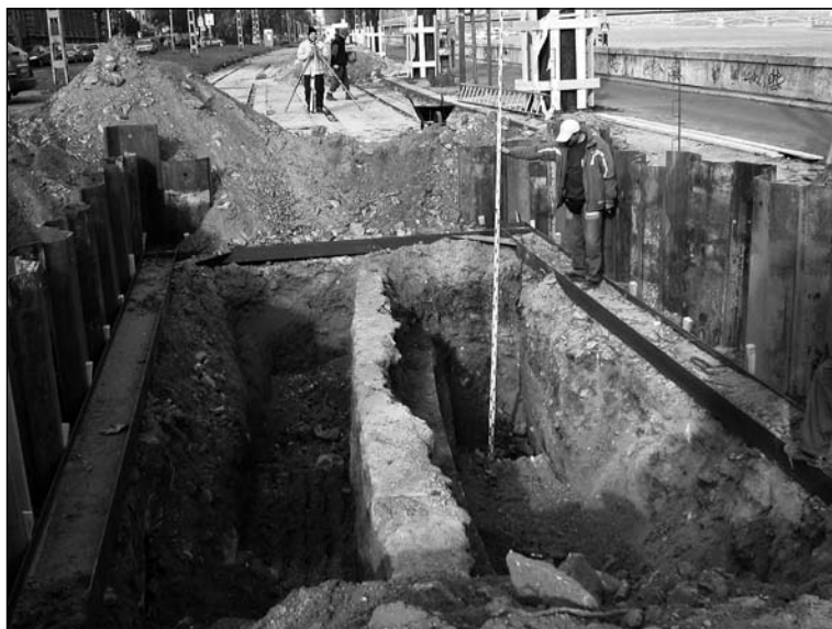
6. kép: Korábbi parti támfal maradványai a 4. akna területén Fig. 6: Section from an earlier retaining wall of the embankment found in Shaft 4; Buda Main Sewer
