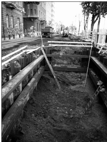
4. kép: A Főgyűjtő csatorna 2. aknája bontás közben, délről
