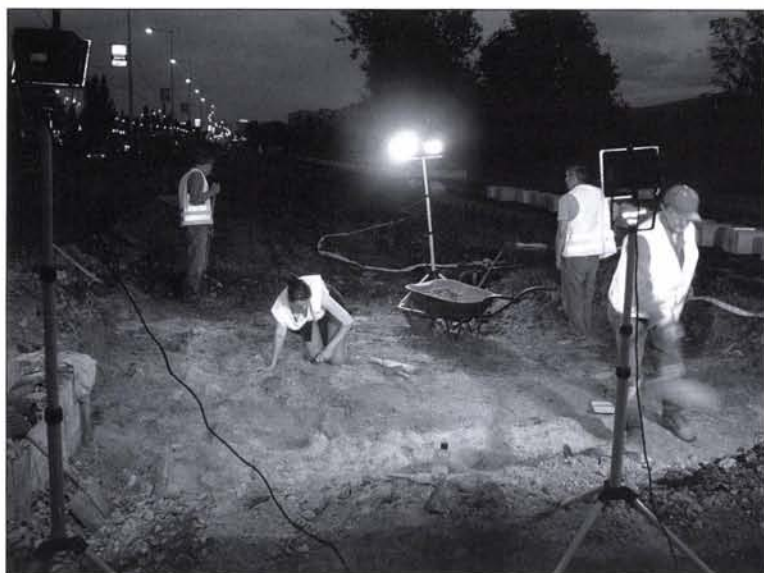
1. kép: Éjszakai régészeti munka a BKV-HÉV pályarekonstrukció során
