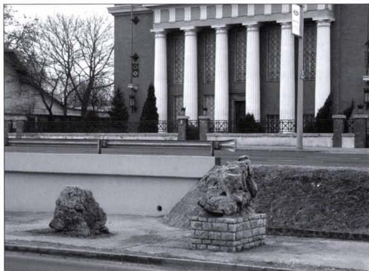
7. kép: Az aquaeductus pillérsora a helyreállított támfallal
