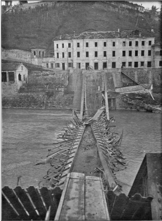
9. kép. A felrobbantott Piave híd Bulleno mellett. 1918. Fotó: Papp Kálmán. Győri Egyházmegyei Levéltár, Papp Kálmán hagyatéka
