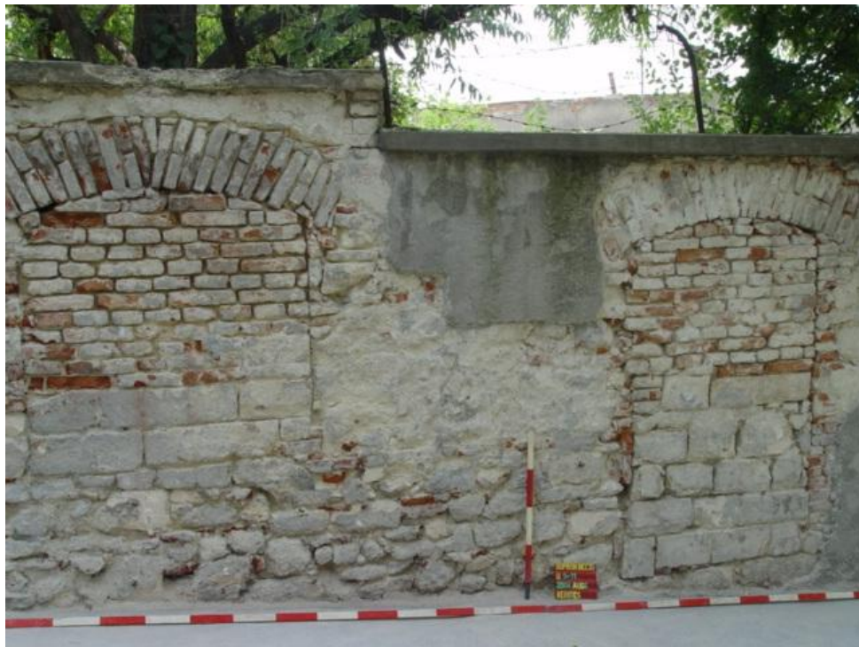
5. kép: A Szélmalom utcai kerítésfal részlete a falkutatás után. (Fotó: Nemes András, 2004.)
