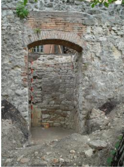
3. kép: Az alsó és felső udvar közti lépcső a feltárás után. (Fotó: Nemes András, 2004.)
