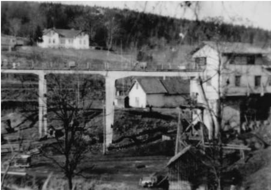
3. kép. Az 1924-ben megépített 90 m hosszú vasbeton híd
