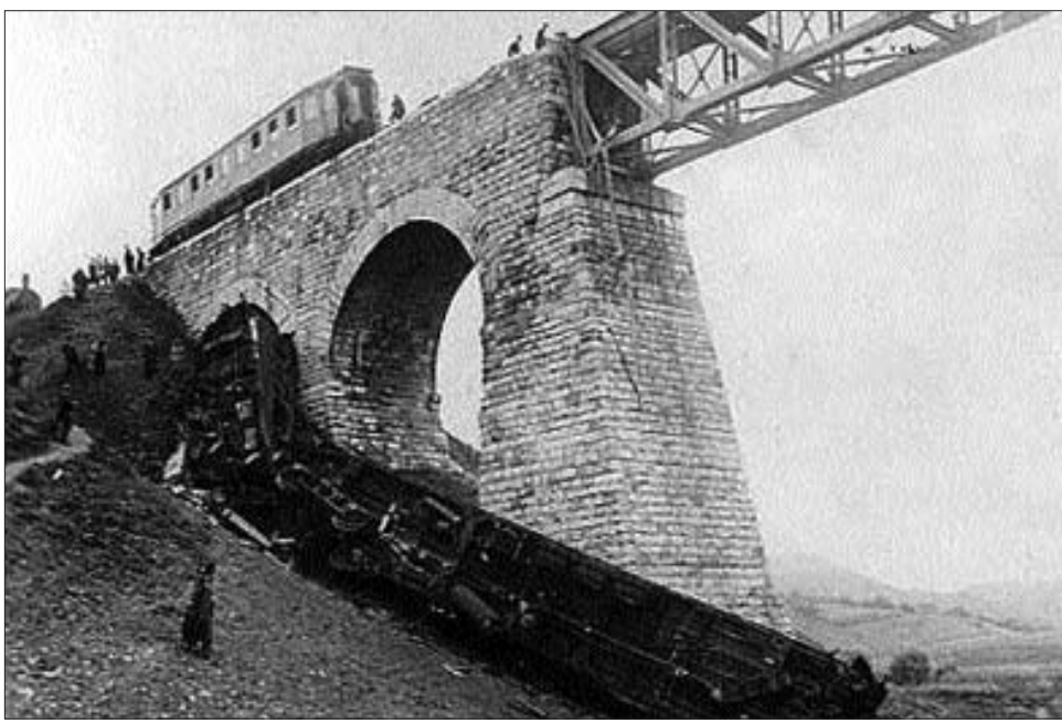
A „biatorbágyi rém” merénylete után: a felrobbantott viadukt és a szakadéka zuhant vasúti kocsij
