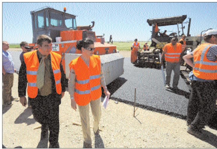
Anca Boagiu szállításiügyi miniszter szemléli a sztrádaépítést Fotó: Mediafax
