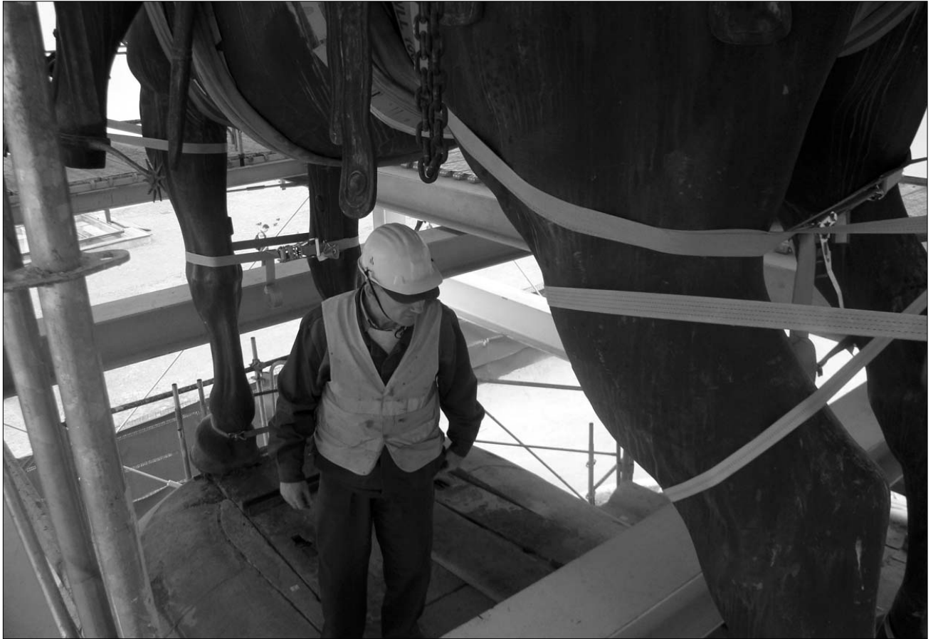
Egyidőben haladhatnak a bronz- és kőelemek restaurálási, valamint a belső mag megerősítésének munkálatai
