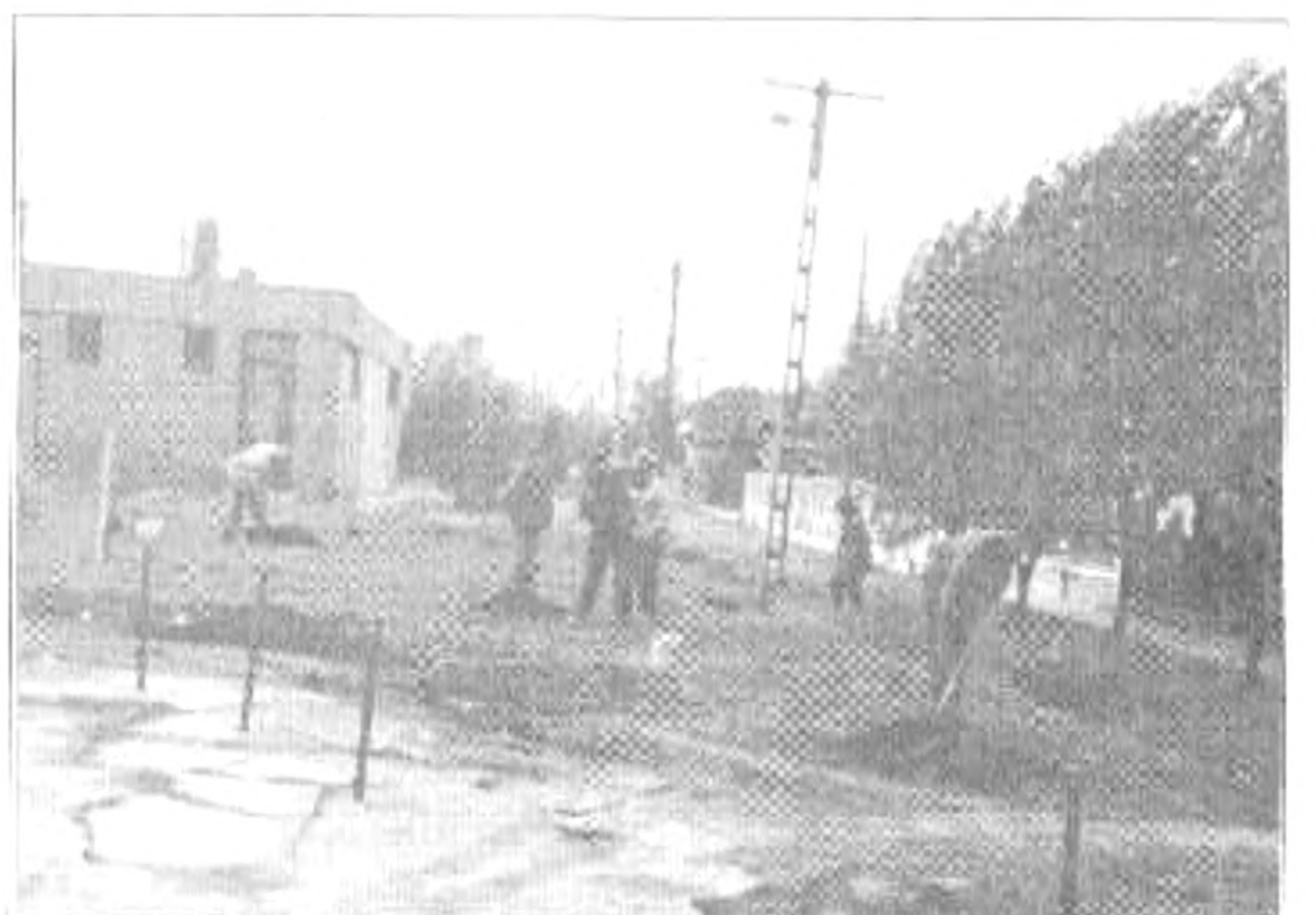
Munkálkodás a buszmegállónál
