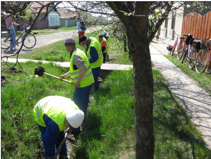
Csatorna tisztítási munkák
