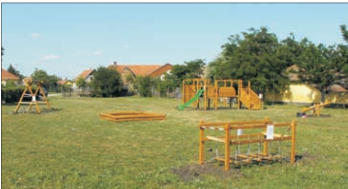
Megkezdődött a Béke téri játszótér építése
