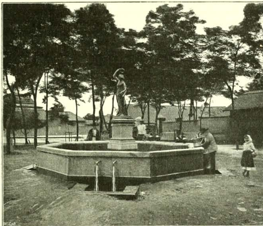
25. ábra. A mezőtúri artézi kút, a Városháztéren. Mélysége 442 méter. A kút kezdetben naponként 1800 hektoliter 22 C° felszökő vizet szolgáltatott. Fúrta ZSIGMONDY BÉLA 1890-ben, fényképezte HALAVÁTS GYULA.
