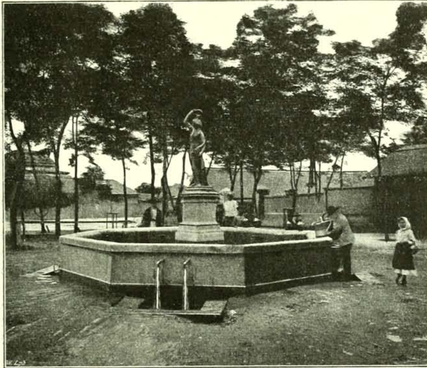
Fig. 25. Der artesianische Brunnen von Mezötúr am Rathausplatz. Tiefe 442 m. Der Brunnen lieferte anfangs täglich 1800 hl aufspringendes Wasser von 22° C. Abgehört von B. v. ZSIGMONDY im Jahre 1890. Photographiert von J. HALAVÁTS.
