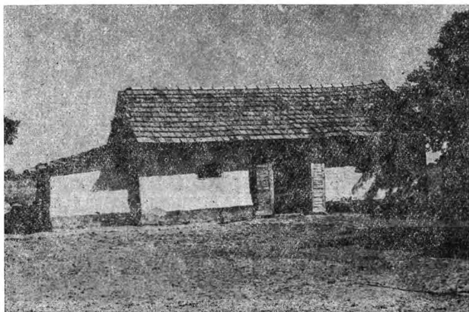
5. Marhaistálló kétszárnyú, tömör deszkaajtóval és fekvő helyzetű ablakokkal. Balra szénásszín. Hódmezővásárhely, Tanya 685.
