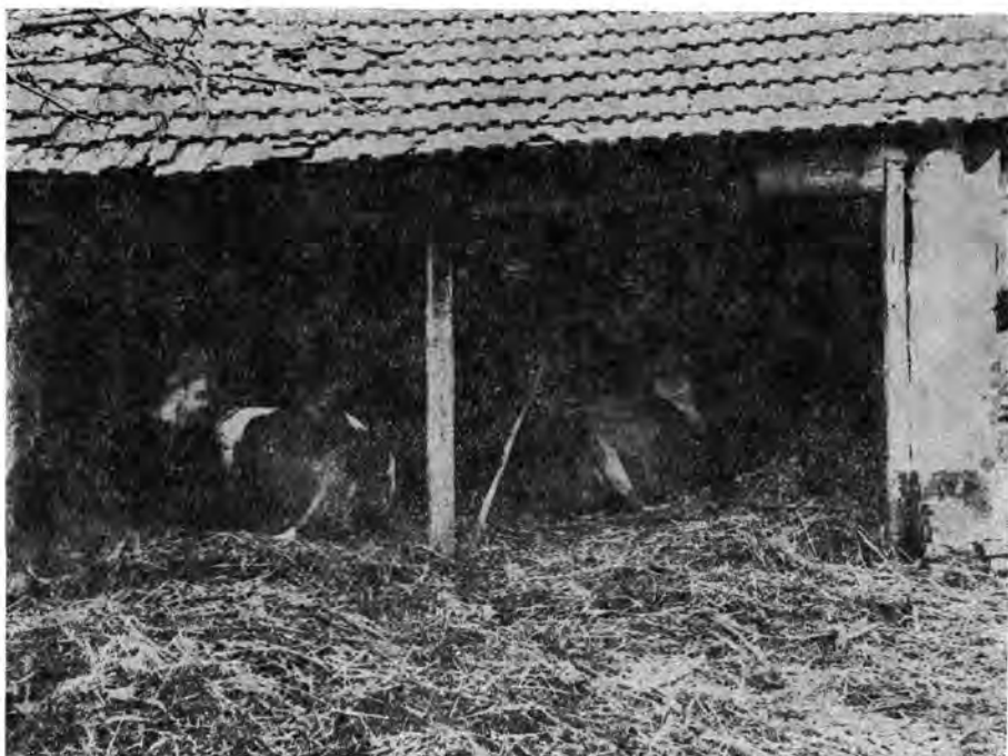
10. Elöl nyitott nyári istálló. Az istálló hátsó falához vályogból építették féltetővel. Mártély, Tanya 64.
