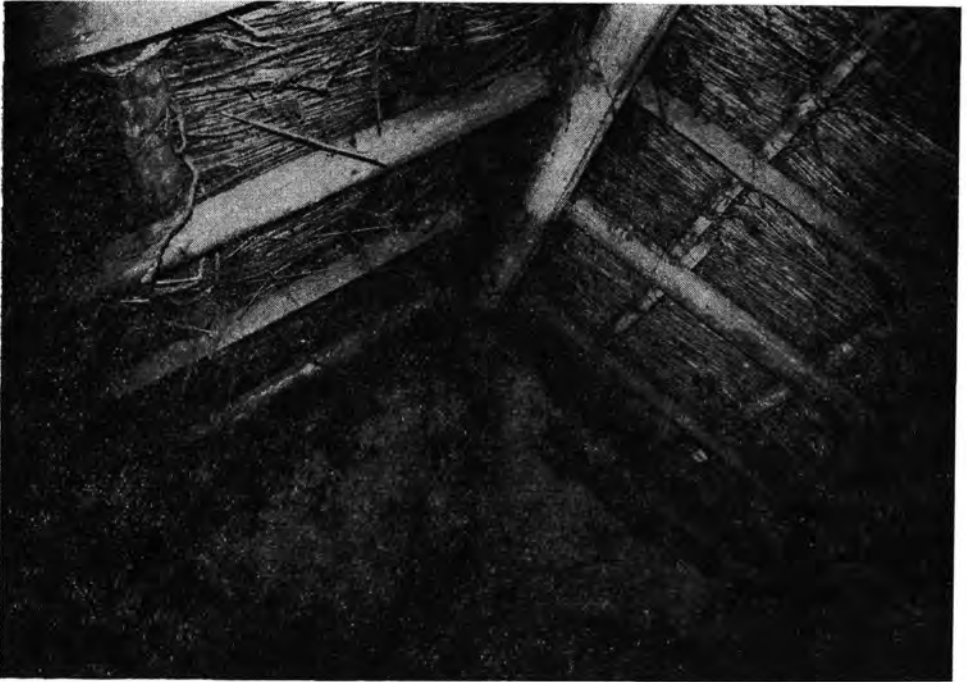
2. Szelemenágasos ököristálló tetőszerkezete. Mártély. Tanya 21.
