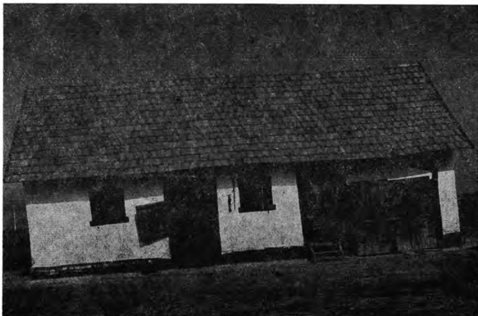
7. Istálló, kocsiszín egy fedél alatt; közöttük padlásfölgjáró. A fal téglából alapozva, felül vályogból rakva. Az ablak- és ajtókeretek, valamint a szín fölötti „szemöldök” feketével van befestve. Hódmezővásárhely. Tanya 670.
