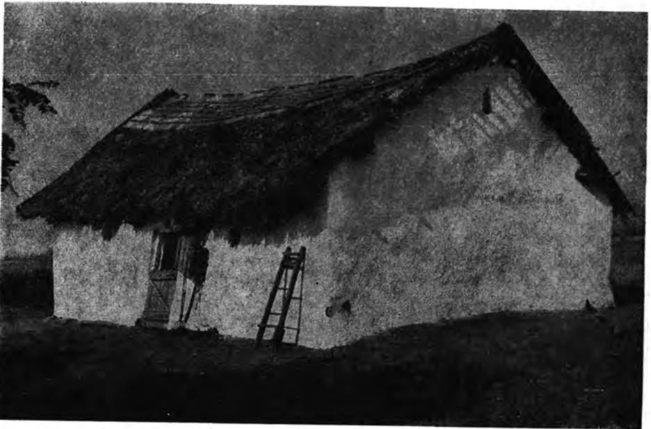
3. Közös ló- és tehenistálló nádtetővel, középen nyíló kétféltáblás ajtóval és szellőzőnyílásokkal. Székkutas VI. ker. 10.
