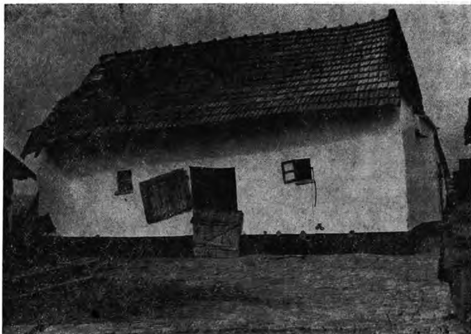
4. Közös ló- és tehénistálló cseréptetővel, egysoros üvegezésű, álló helyzetű ablakokkal. Székkutas. VI. ker. 16.
