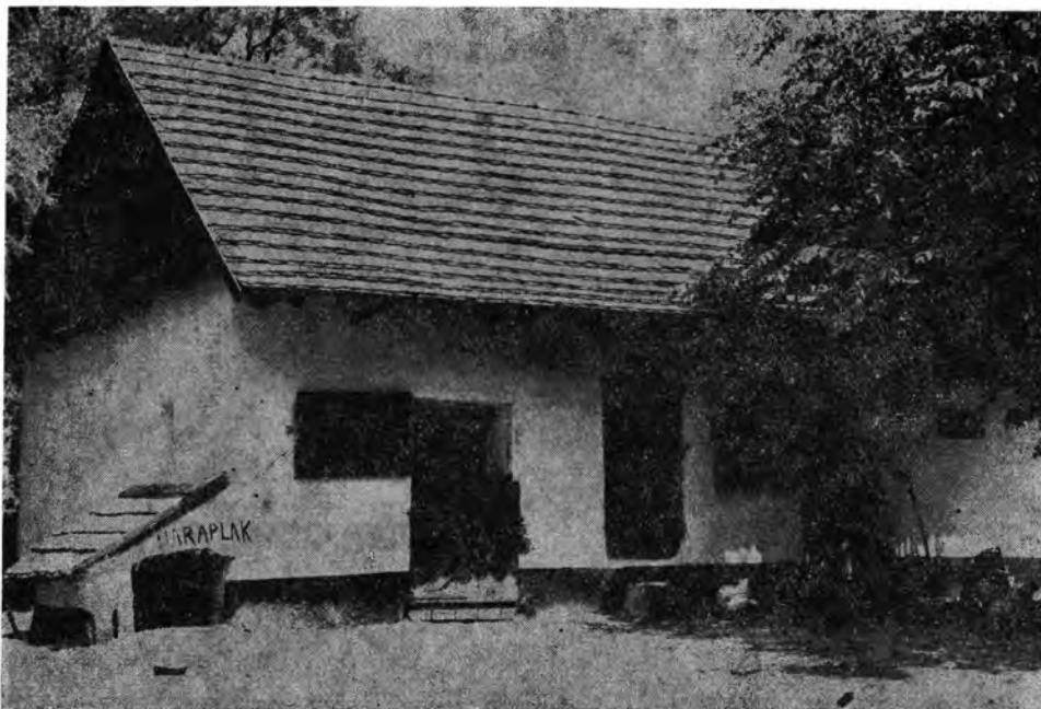
6. Ló- és marhaistálló közfallyal elválasztva, egy fedél alatt. Középen padlásfeljáróval, álló vég- és fekvő homlokzati ablakkal. Hódmezővásárhely, Tanya 2026.
