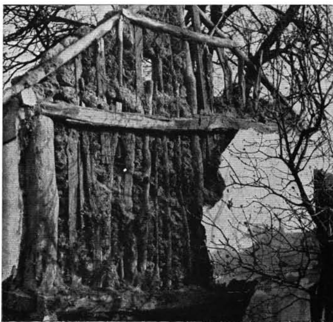
11—12. kép. Karóvázas szerkezetű tapasztott hambárfal részletei, Ásotthalom 997
