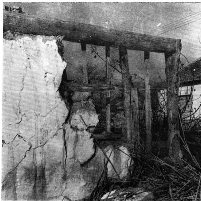
5. kép. Oszloposház váza és csömpölyegfala bontás közben, Tápé, 1973.
