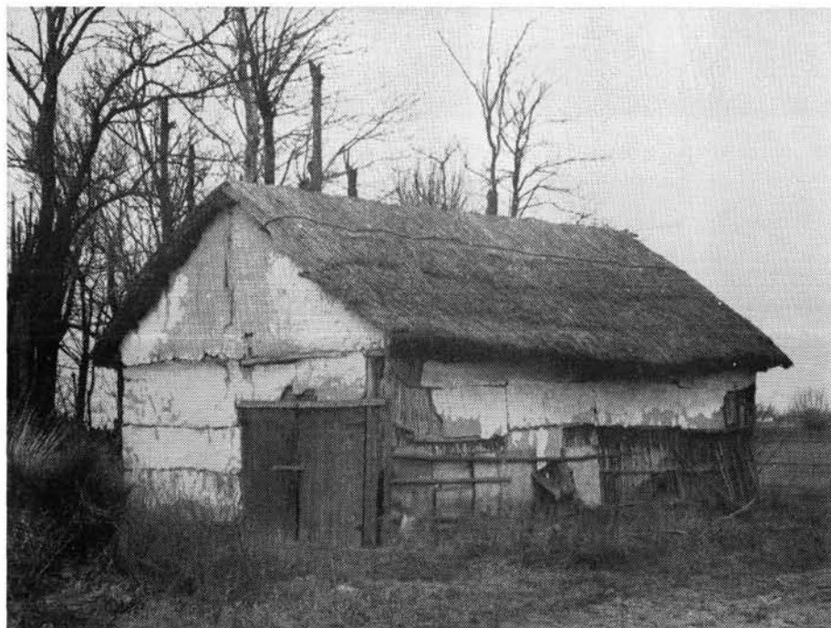
8. kép. Napraforgószárra tapasztott tutajfalú polyvásszín, Mórahalom
