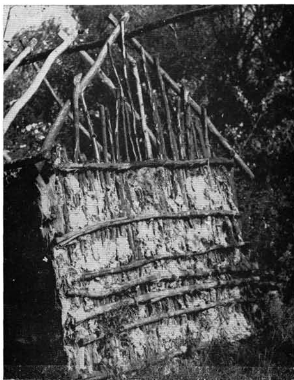
17—18. kép. Karó- és nádvázás, tapasztott sárfalú halászkunyhó, Tiszakürt, 1979. Solymos Ede felvételei
