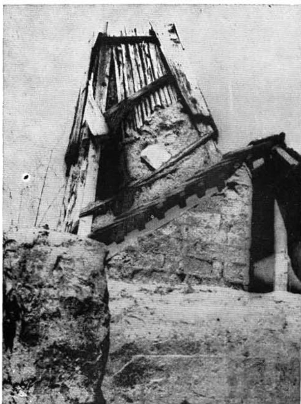
16. kép. Léc- és napraforgószár-vázás, tapasztott kémény
