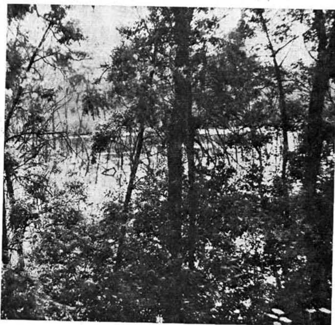
A szilléri csatorna
