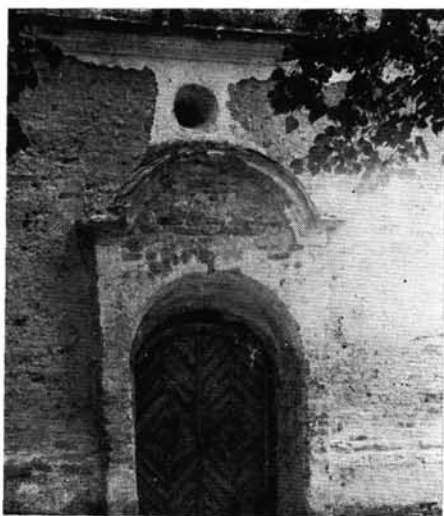
16. A lábodi temetőkápolna NY-i homlokzata tatarozás közben (1977)
