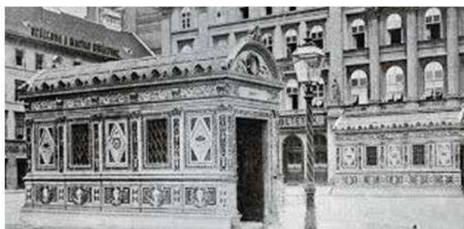
Line under construction on Andrásy út at Városliget; Andrásy út with the Millennium Underground (1896); Kiosk at Városliget
