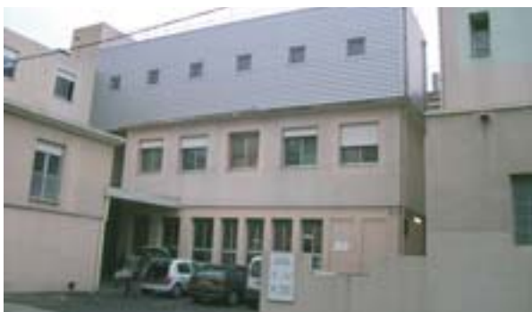
A Bonnefon-klinika tetején a műtéti blokkot tartalmazó modul egységet állítottak fel
