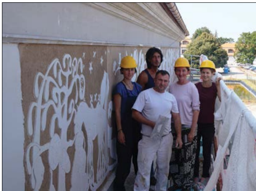
Makoldi Gizella és csapata a sgraffito munkálatai közben
