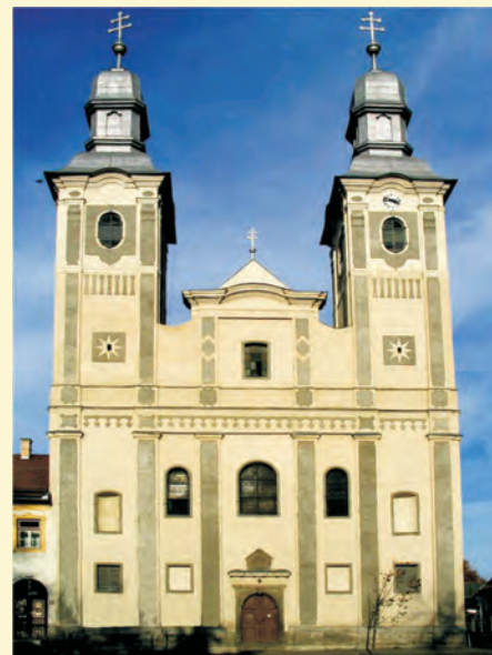
Főhomlokzat. Fotó: Kovács Árpád
