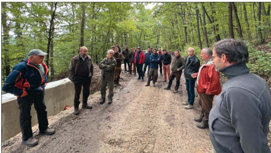
Pilisszentkereszt, Kakas-hegy – cölöp alapsorra helyezett vasbeton fejgerenda megtámasztás
