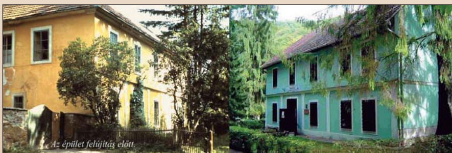
A múzeum épülete a felújítás előtt és után
