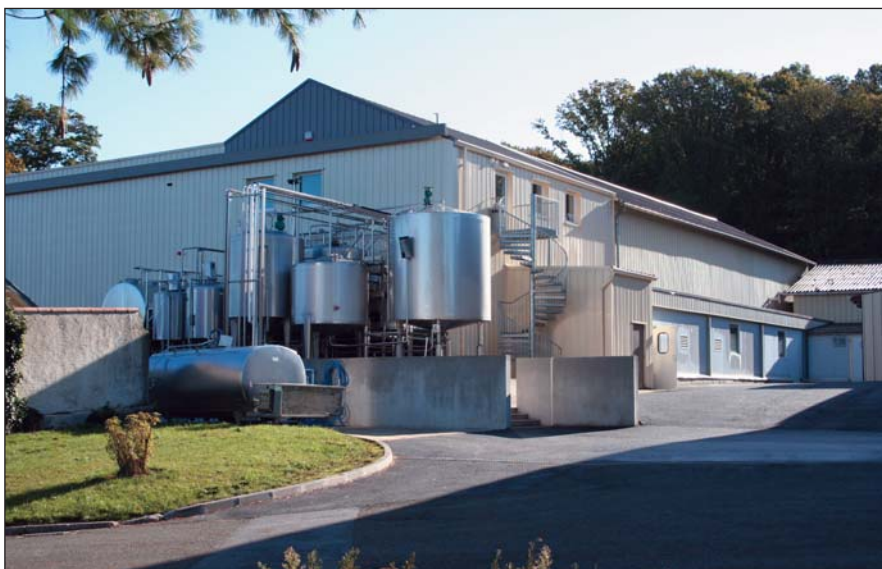
Tejfeldolgozó kisüzem Párizs közelében, a technológiai melegvizet és a szükséges egyébből egy saját erdőben termelt fára alapozott biomassza-kazán biztosítja
