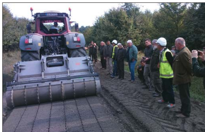
1. Előtörés, vontatott kalapácsfejes törőgép profilozó hengerrel (Fendt 936 traktormeghajtás)
