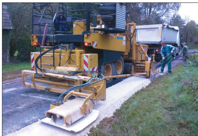
4. Padkafinisher (hátsó hidraulikus tömörítőpad)
