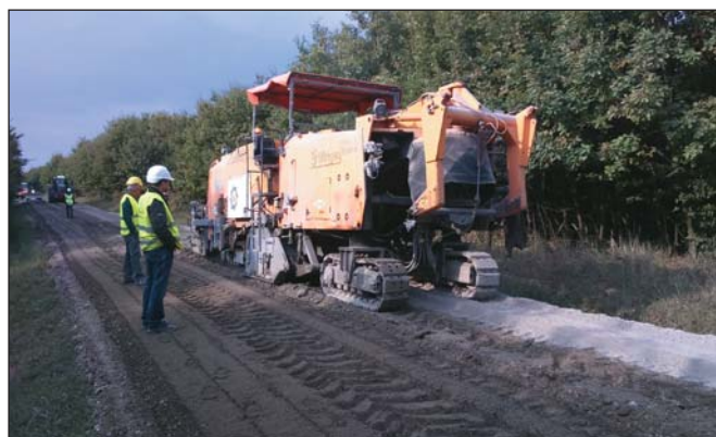
2. Finommarás Wirtgen hidegmaróval és vízbe keverés az elő-mart, cementtel terített felületen
