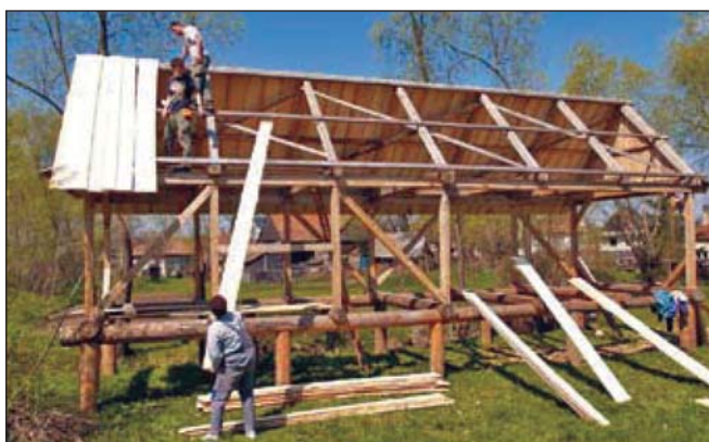
A tető deszkázása
