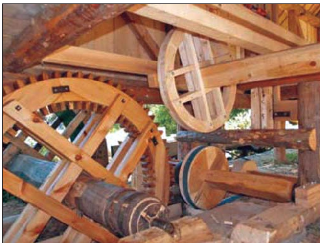
A beépített bajtásmű
