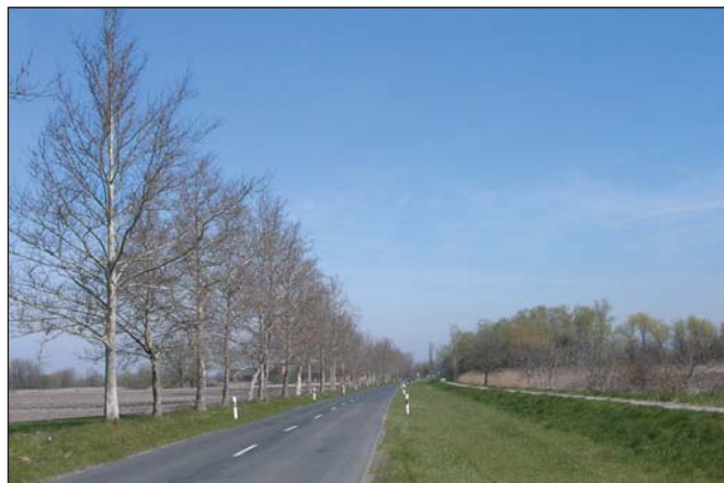
1. kép. Elnéző útpadka és külső sáv Fertőd-Nyárliget között (Fotó: dr. Takács Viktor)
