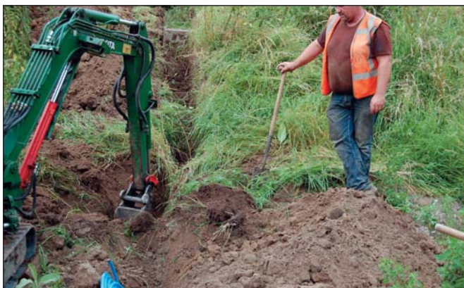
8. kép: Árokásás fűz energiaültetvény bővítéséhez
