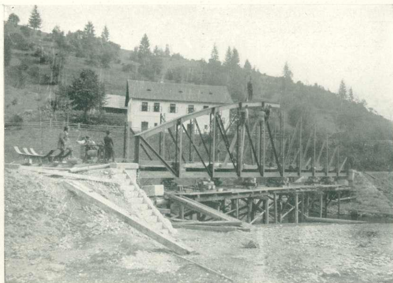
4. kép. 30 m nyílású 'híd' Kisgaramon 'szerelés közben.
