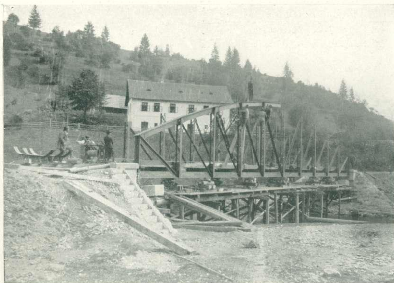
4. kép. 30 m nyílású 'híd' Kisgaramon 'szerelés közben.
