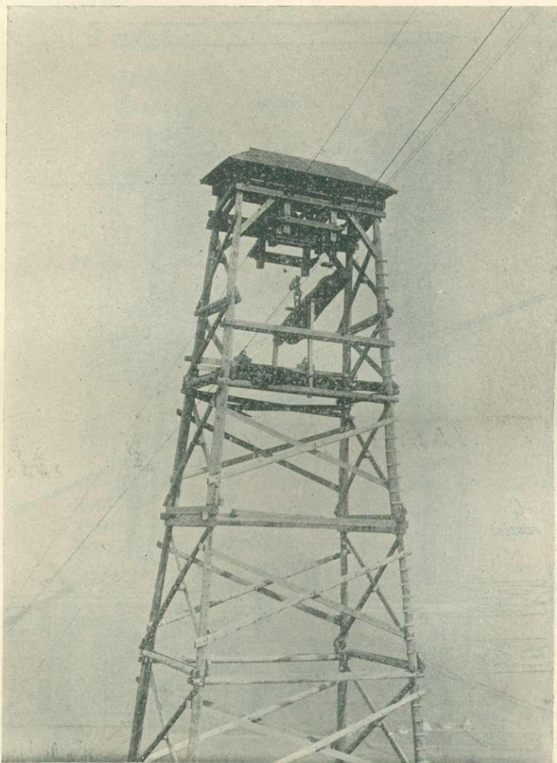
21. ábra. Az igmanhegyi drótkötélpálya legmagasabb alátámasztója.
