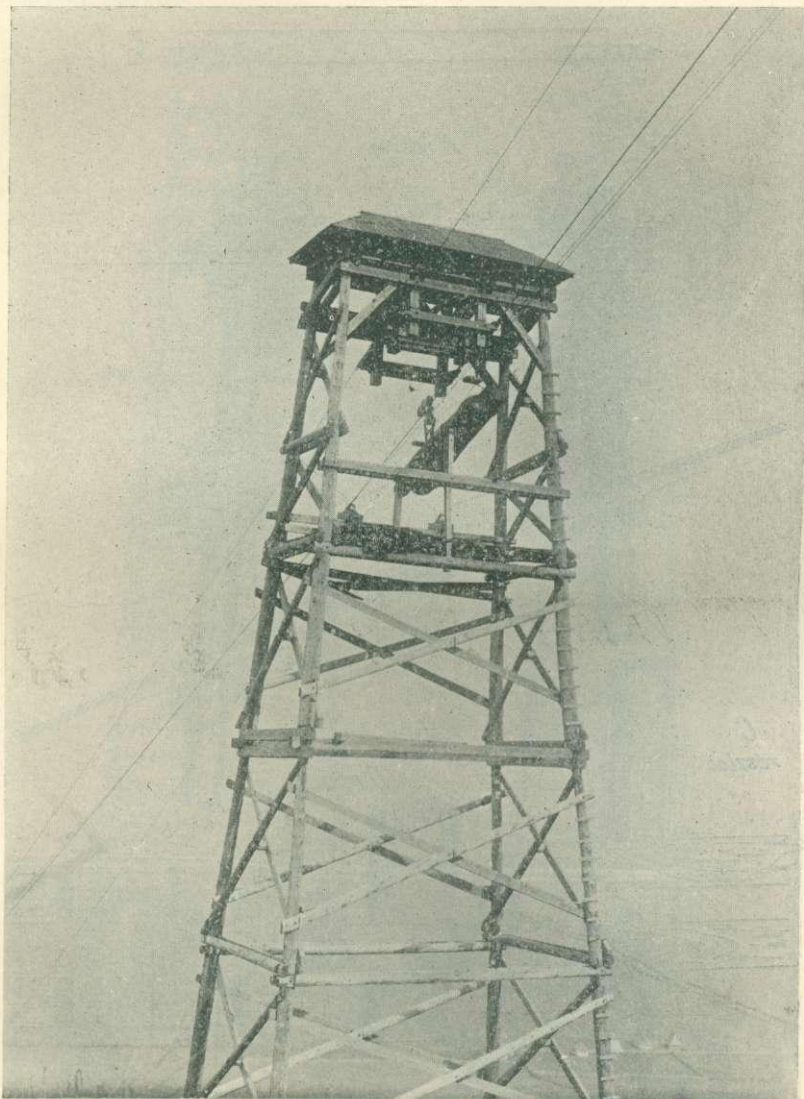
21. ábra. Az igmanhegyi drótkötélpálya legmagasabb alátámasztója.
