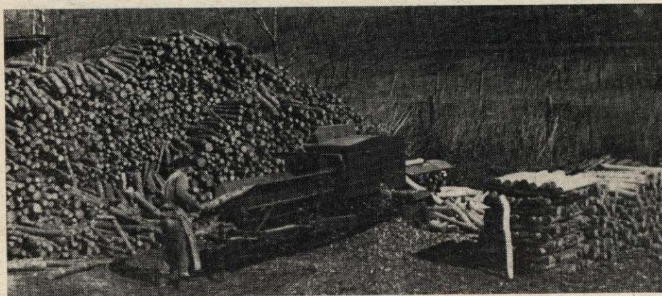
5. ábra. KR—2-es egri forgógyűrűs kérgezőgép
