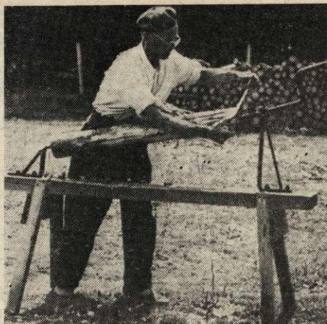
2. ábra. Kérgezés vonókéssel — 5% faveszteség
