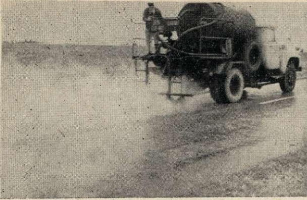
2. ábra. Bitumenemulzió permetezése
