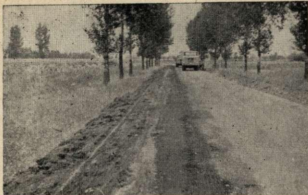
6. ábra. Burkolatkészítés bitumenemulziós keverékekkel (hideg kavicsaszfalt)
