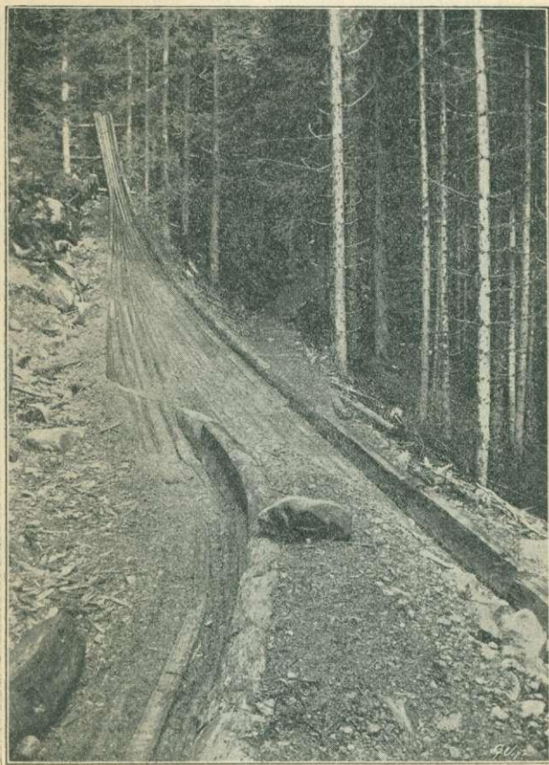
42. kép. A Zocchi csuszató B csucsfordulója.
