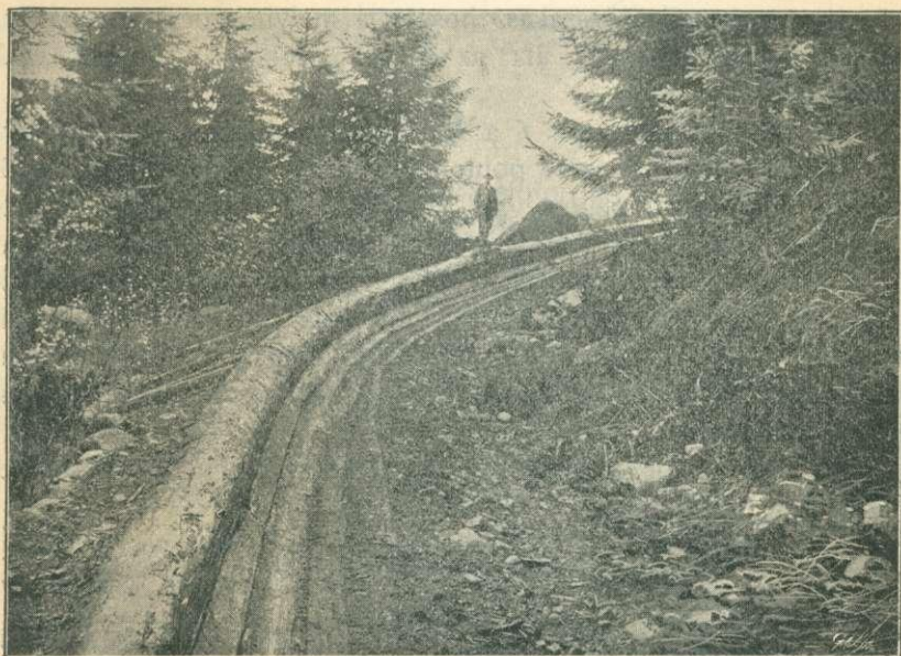
44. kép. Kanyarulat a Zocchi csusztatón. R = 6\text{ m} ; esés 26\% .
