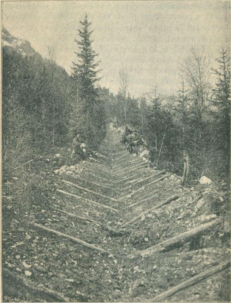
10. ábra. Eibl csuszató ut. Egyenes szakasz, ferdén fekvő kettős bordákkal szerelve.
