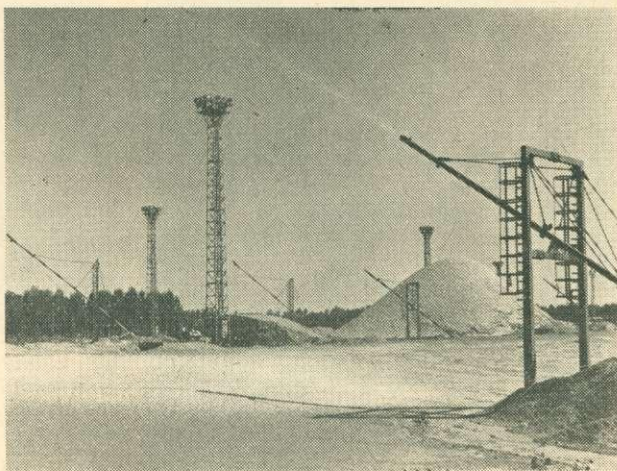
Pneumatikus forgácscsállítás tároláshoz
