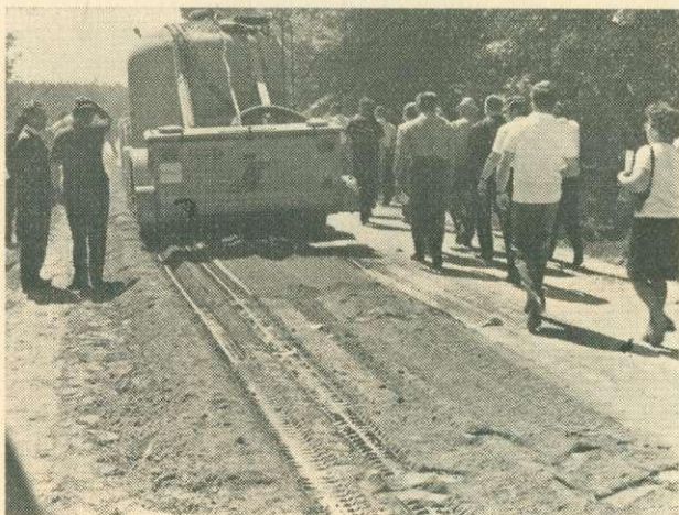
Cementterítés az útstabilizációhoz
