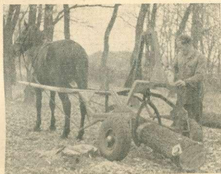
3. ábra: Fűrészrönk-felterhelés közelítő kerékpárral.
