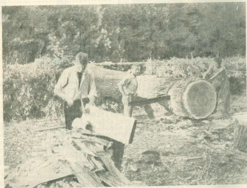
11. ábra. A donga kézi feldolgozásával járó anyagpazarlás
