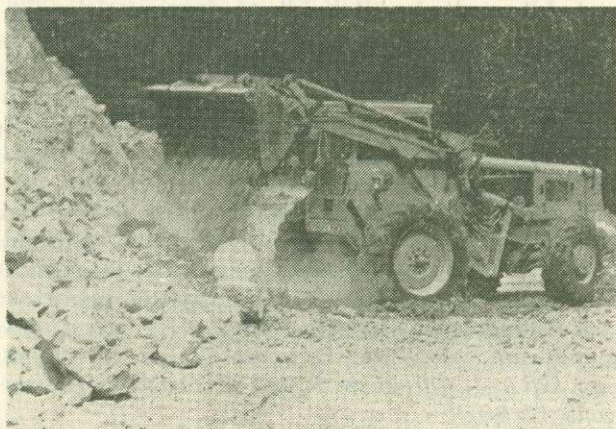
Robbantott szikla rakodása VOLVO homlokraudóval
