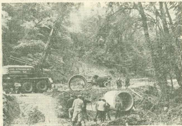
ROCLA vasbetoncsövek elhelyezése
