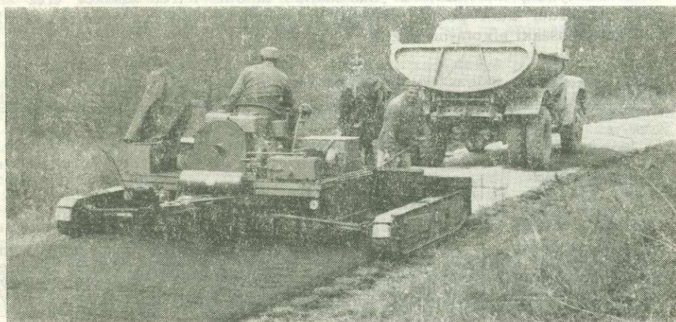
Aszfaltos útfelújítás a Cserépfalu—Mocsárárháza úton, 1976
